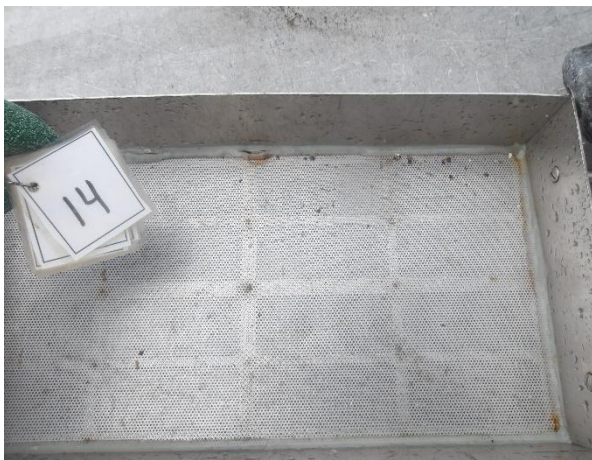
Ingen sediment å skylle
